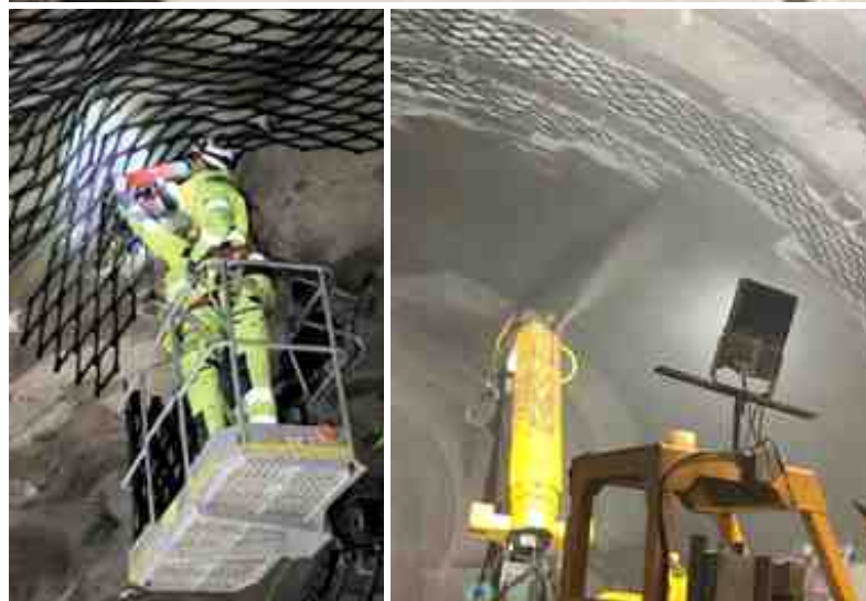
Fig. 4: Instalación de drenaje Dolenco en la corona del túnel y posterior recubrimiento con otra capa de hormigón proyectado.
