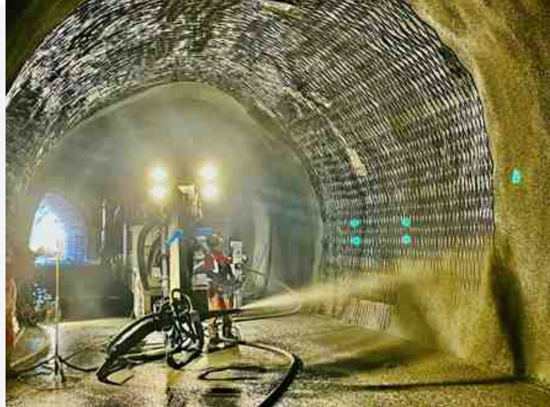
Fig. 6: Renovación del túnel de carretera con filtraciones La Tzoumaz, Suiza
