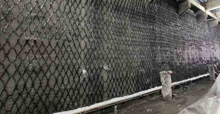
Fig. 5: La estación de tren REM en Montreal, Canadá
